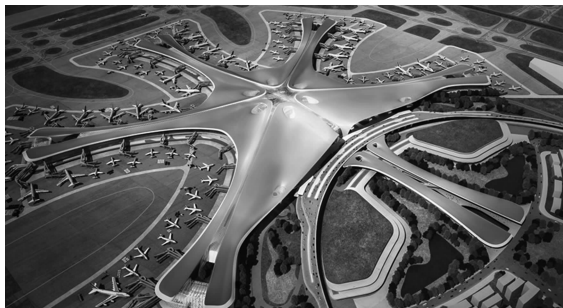
图 1-1 北京大兴国际机场
