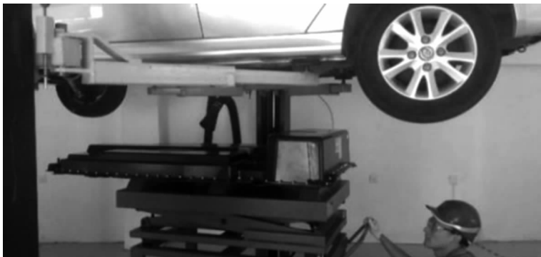
图 1-52 放下动力电池
