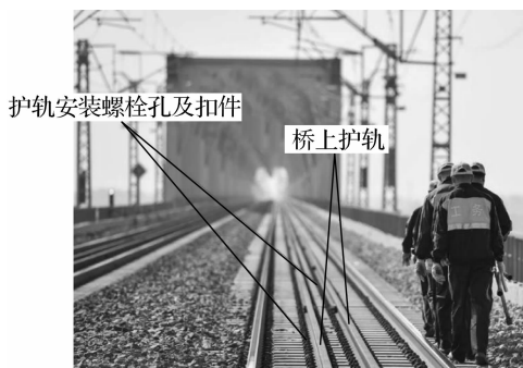
图 1-56 桥上Ⅲ型混凝土枕
