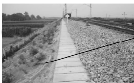
图 1-24 铁路路基的高路堤
