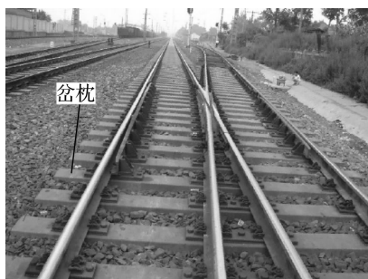
图 1-57 道岔上的Ⅲ型混凝土枕
