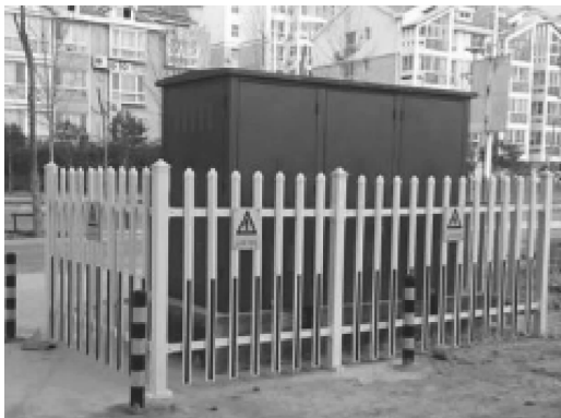
图 1-14 电气护栏
