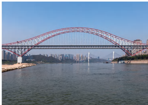
重庆朝天门大桥
