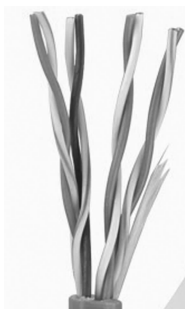
图 2-34 剥离后的四对八条芯线
