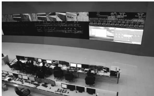
图 2-8 ATS 系统对地铁全线的监控、调度
