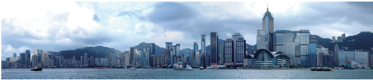
图 1-5 城市高楼大厦的图片素材
