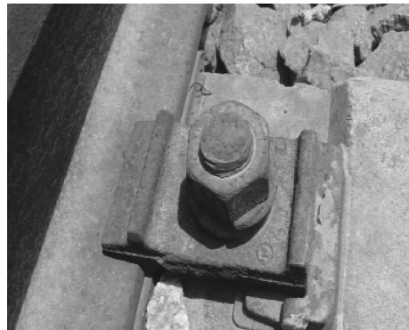
图 3-37 混凝土枕扣板式扣件
