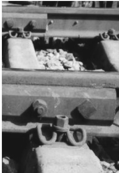
图 3-39 混凝土枕弹条式扣件
