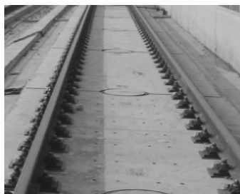
图 3-44 无枕式整体道床
