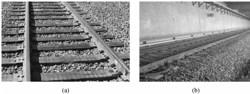
图 3-43 碎石道床 (a)木枕碎石道床 (b)钢筋混凝土枕碎石道床
