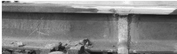
图 3-23 焊接后的钢轨
