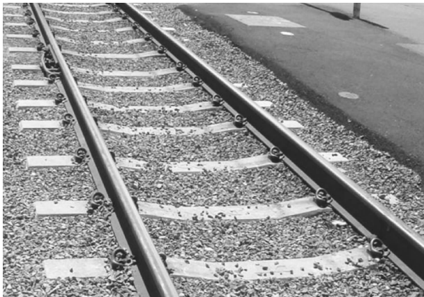
图 3-27 钢筋混凝土枕
