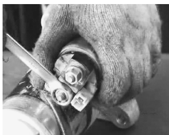
图 3-12 电磁开关接线柱紧固螺母拆卸
