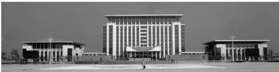
图 11-22 某行政办公楼
