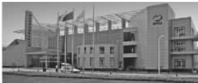
图 8-17 东风汽车集团公司总部大楼
